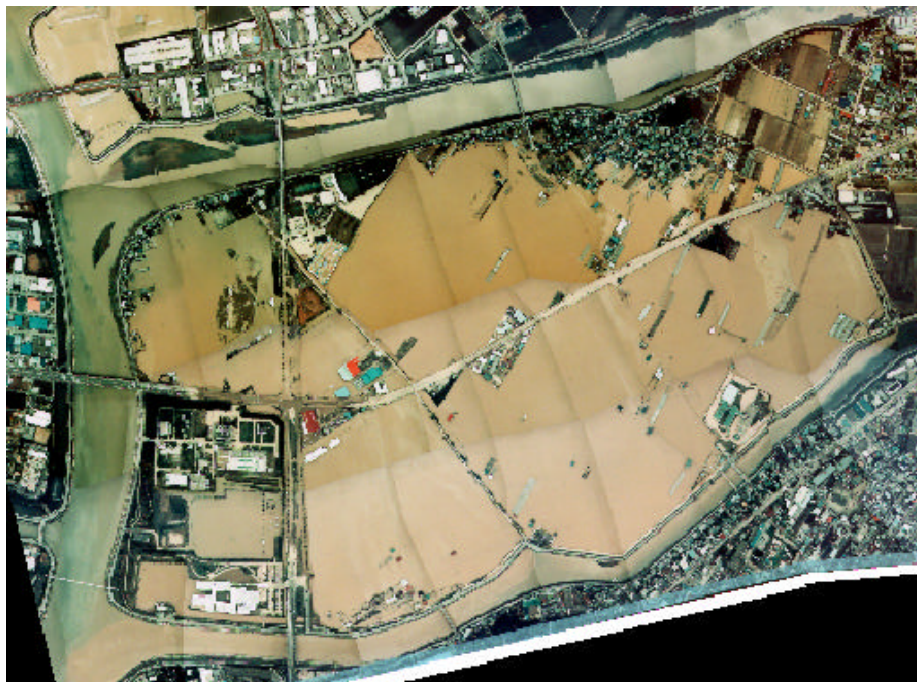
航空写真による被害状況
