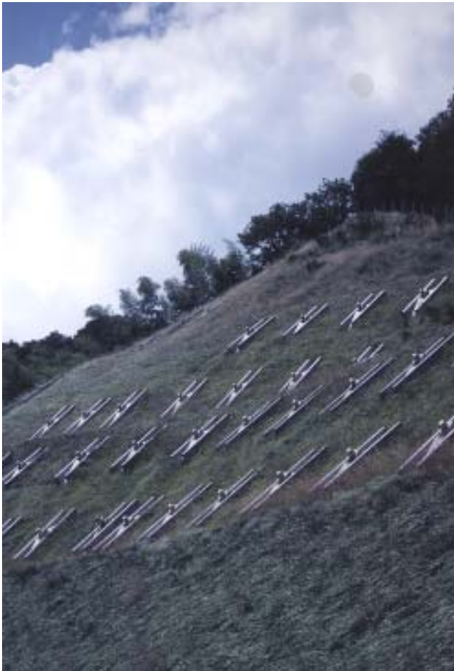
写真-9 新しく開発されたアンカー受圧版
