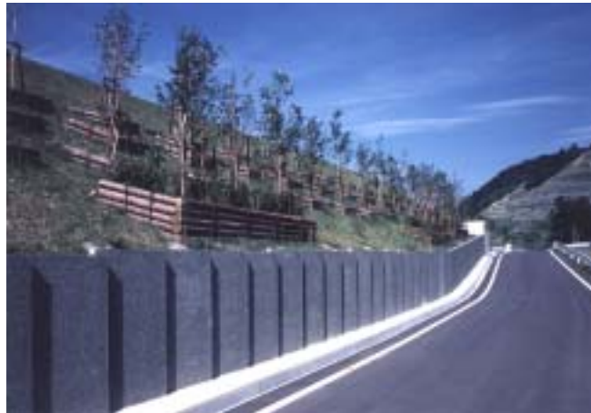
写真-16 L型擁壁と盛土
