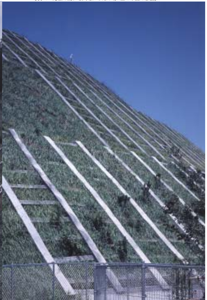
写真-10 工学的に要求されたのり枠と緑化を同時に配慮
