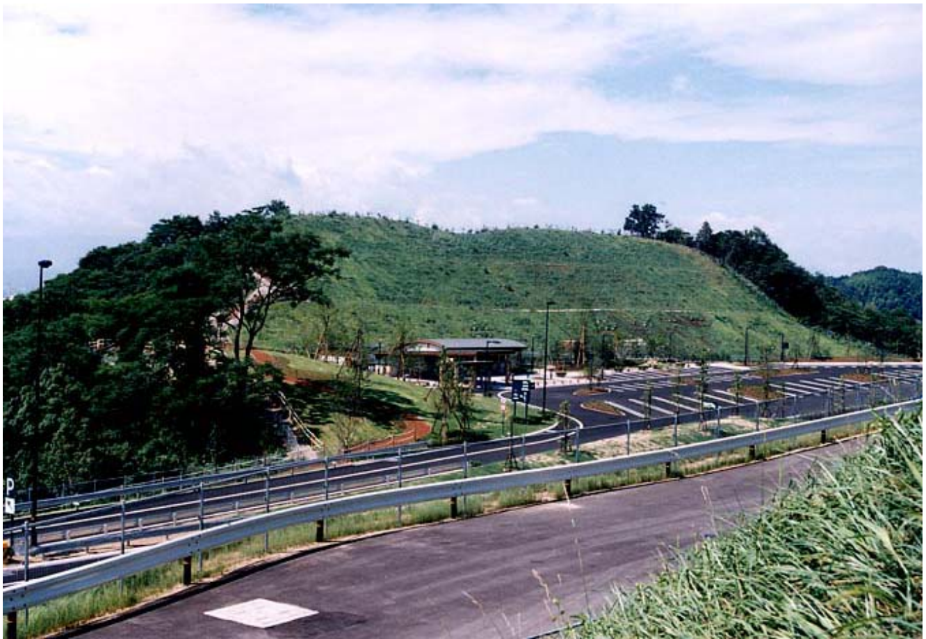
写真-18 下り線パーキングエリア
