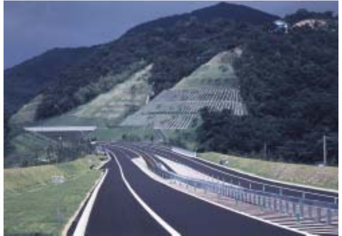
写真-8 尾根の流れを大切にしたの切土のり面の景観。
