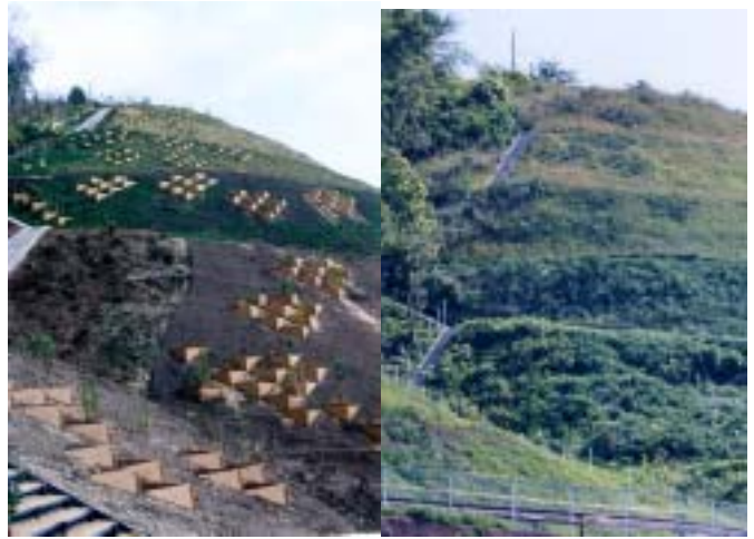
写真-7 自然配植緑化施工直後(左)、4ヶ月後(右)
