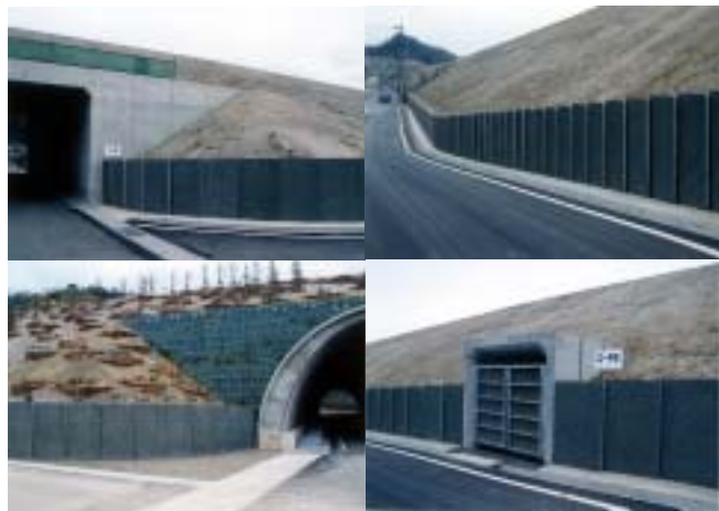
写真-14 L型擁壁のおさめ(曲線配置、縦断勾配、アテ、ヌケ等)
